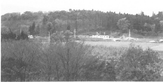
▲浄水場、配水池予定地の赤羽山
