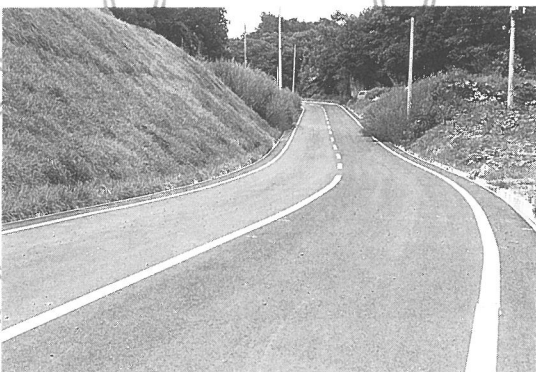
▲農用地総合整備事業（板橋地内）
