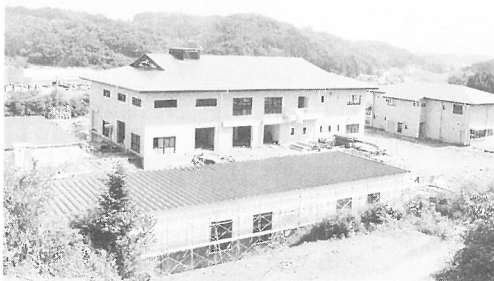
▲平成8年3月完成をめざして工事が進められるし尿処理施設
