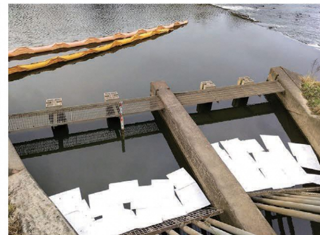
オイルマットを敷設している様子
