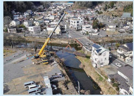
今須橋上部工撤去作業の様子
