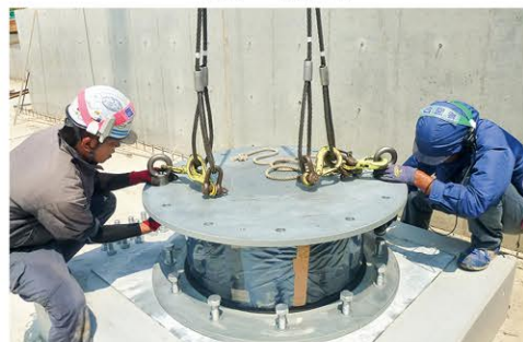
▲8月 免震装置設置
