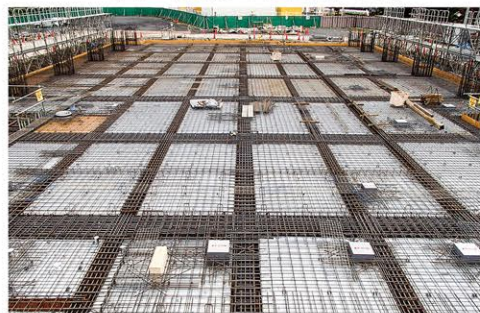
▲9月 1階基礎工事（配筋）
