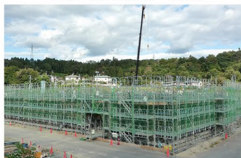
▲10月 1階躯体工事
