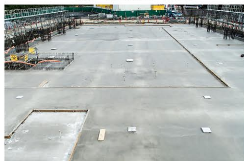
▲9月 1階基礎工事（スラブ打設）
