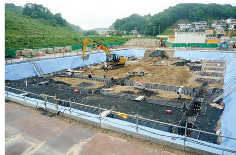
▲6月 基礎（地中梁）工事
