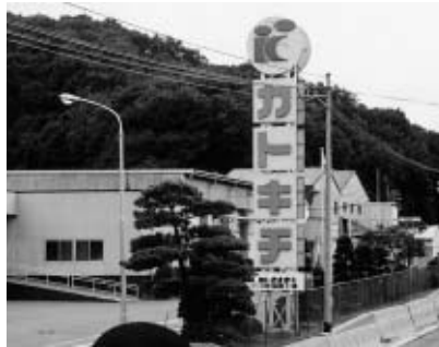
加ト吉水産(株)フーズ部福島工場
