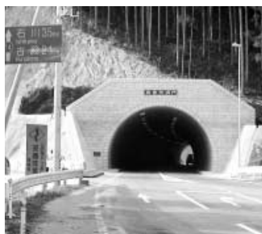
▲昨年12月27日開通した御齋所洞門（いわき市遠野町）
