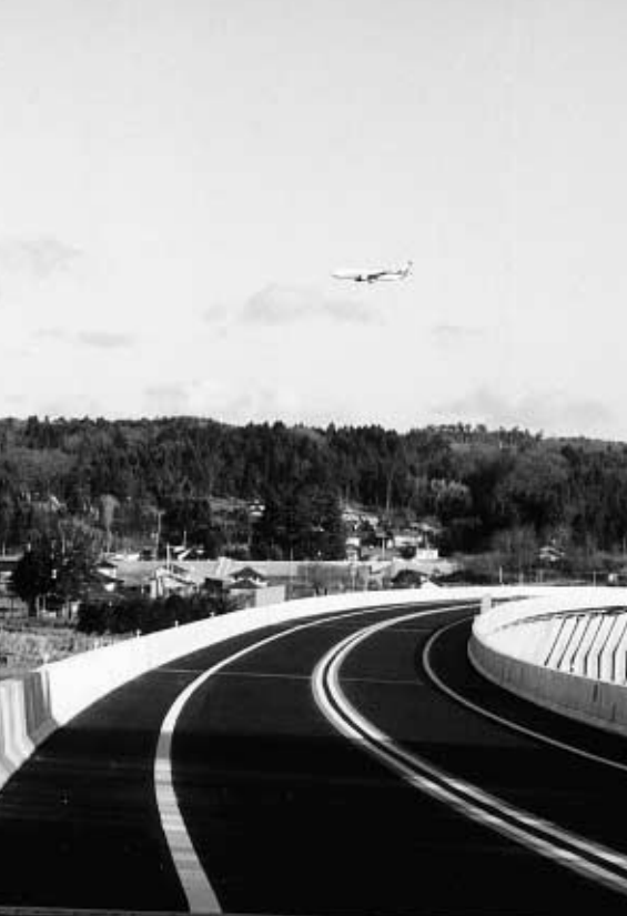
▲3月27日一部供用開始された「あぶくま高原道路」
