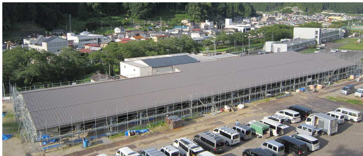
建設中の石川町立認定こども園
