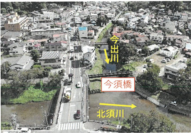
河川改修事業着手前
