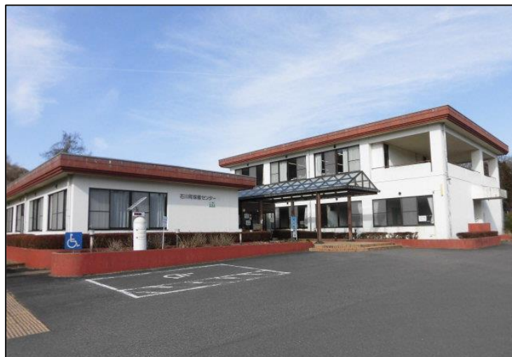
(写真は石川町保健センター)
