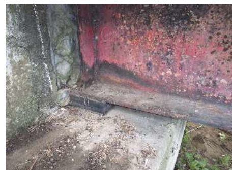
23. 共和橋 : 鋼H桁橋 (橋長 : 40.78m、1964年竣工) 主桁端部の板厚減少 ※支点上での板厚減少により、耐荷力の低下が推測される。(迂回路有り)
