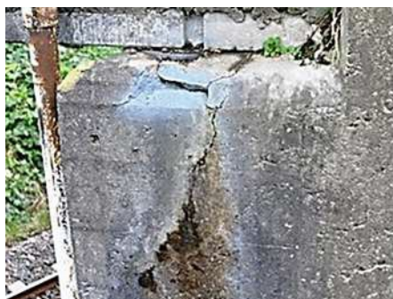
48. 1001号橋 (町屋橋) : プレテン床版橋 (橋長 : 12.65m、1967年竣工) 橋台側面の漏水を伴ったひびわれ ※地震等の外力により断面欠損へと進展する可能性が高い。(迂回路有り)
