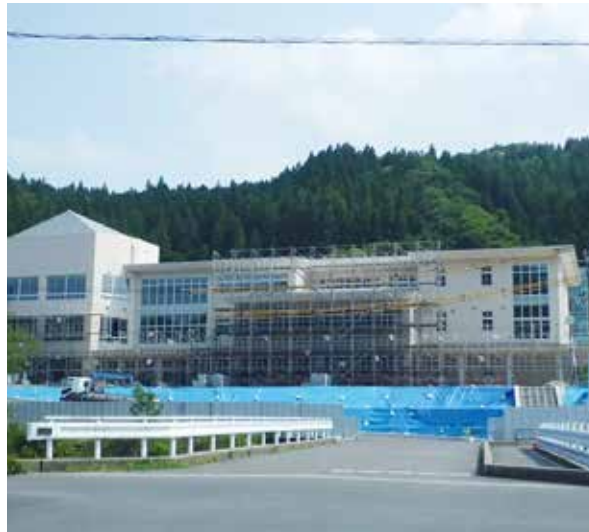
▲工事が進む新校舎
