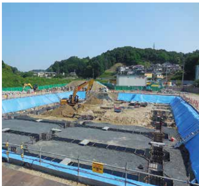
▲基礎工事まで進んだ新庁舎
