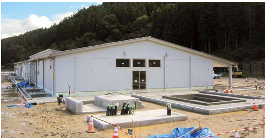
工事が進む認定こども園(令和6年11月末時点)
