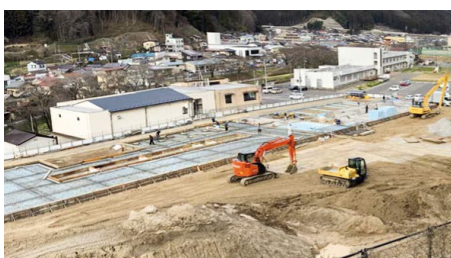
こども園基礎工事が進んでいます(4月2日撮影) 石川町の文教地区として相乗効果が期待できます
