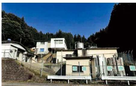
改修事業が一時中断された浄水場
