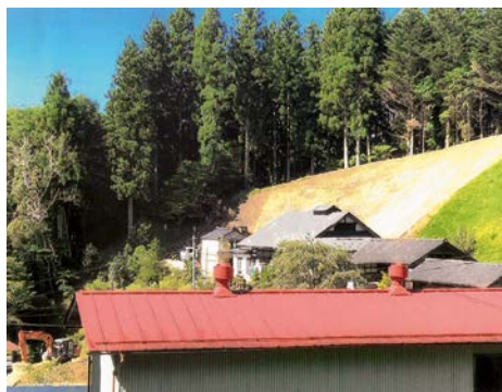
▲保安林の治山工事の様子
