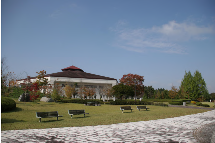
(写真は石川町総合体育館)
