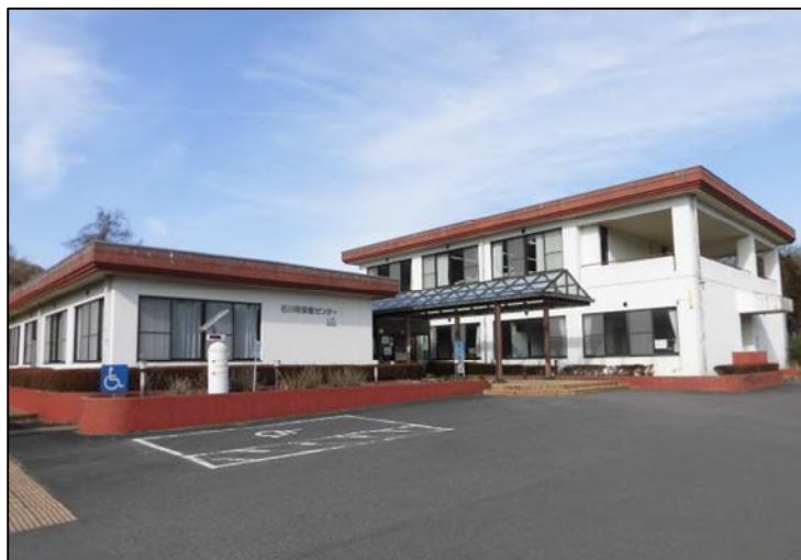
(写真は石川町保健センター)
