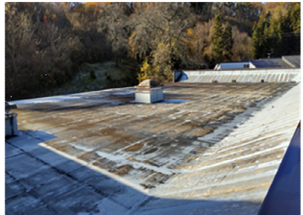
【山橋自治センター屋根の状況】
