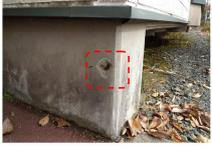
●基礎の鉄筋の露出
