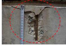
●コンクリート部分のはく落（欠損）、鉄筋の露出
