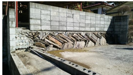
中田地区に見られる變成岩を利用した「矢羽根積み」擁壁
