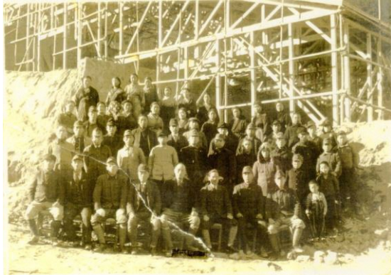
ジルコン選鉱工場上棟 （基礎遺構は福島県立石川高等学校に所在）
