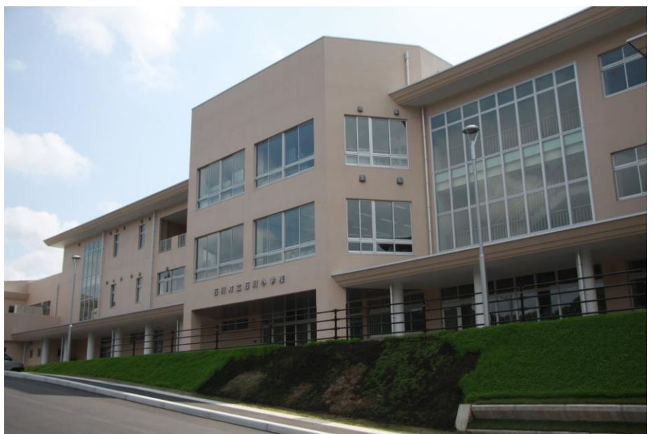
新石川小学校校舎… 完成しました！
