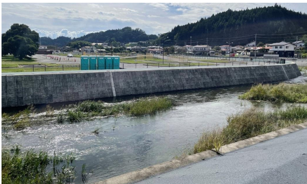
復旧した護岸の状況
