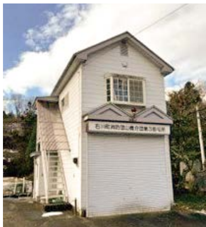
消防団山橋分団第3部屯所の様子
