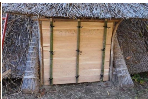
平安住居新入口扉取付け
