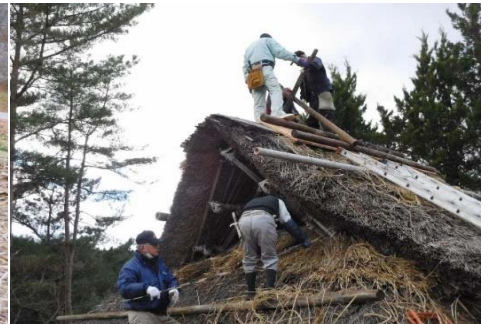
挿し萱・合掌（挿み）取付け作業
