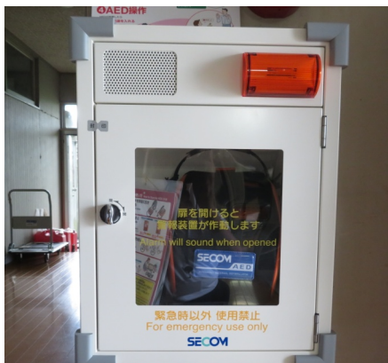
正面玄関入って右側に設置
