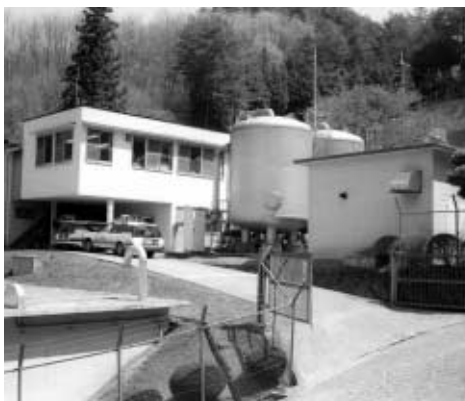
▶管理棟・活性炭ろ過機
