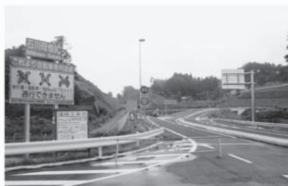
▲完成間近の石川母畑インターチェンジ
