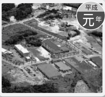
西部工業団地が完成
