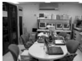
石川町 IT の拠点サーバー室
