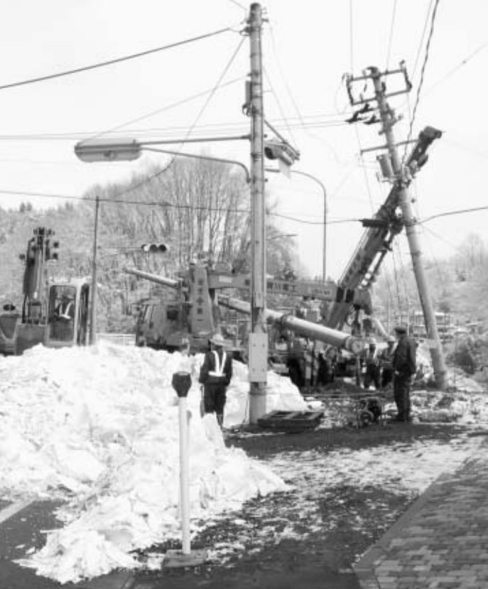
◀路面凍結により大型トラックが横転。電柱を倒し積み荷のパルプ材が散乱。
