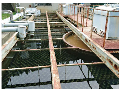
▲腐食が進む沈殿池 (母畑浄水場)
