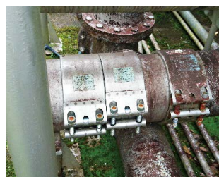
▼補修されたパイプ (母畑浄水場)
