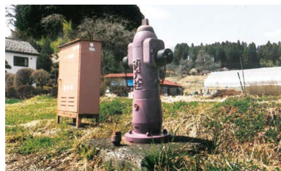
▲急がれる上水道整備と消火栓の設置
