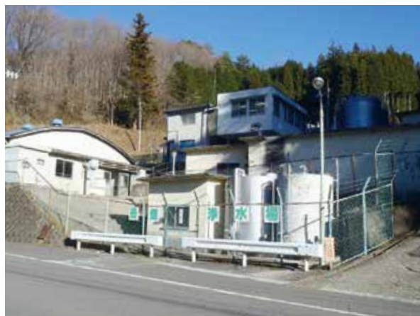
▲老朽化が進む母畑浄水場
