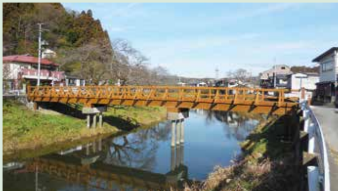
▲完成した泉橋
