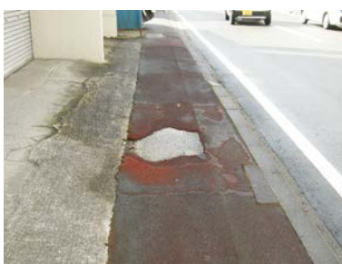
▲改修が進まない歩道
