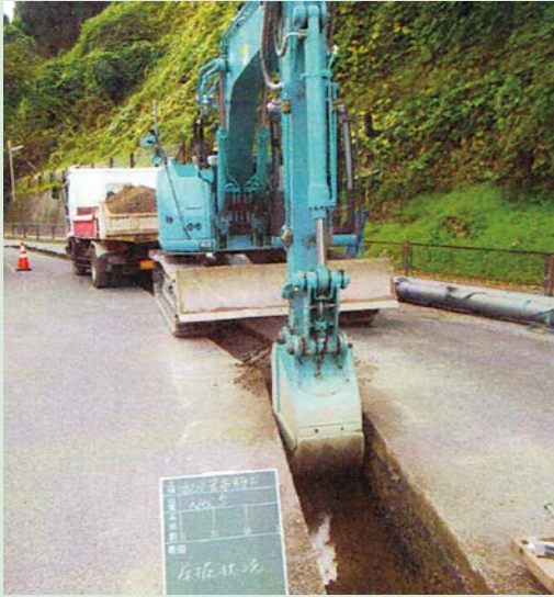
▲石綿セメント管の更新作業
