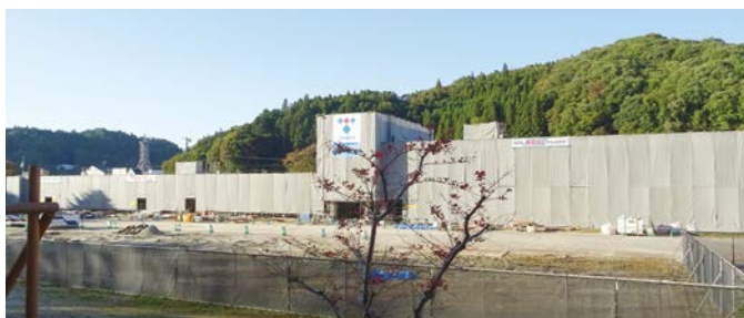
▲ 来年4月オープンに向け工事が進む文教福祉複合施設
