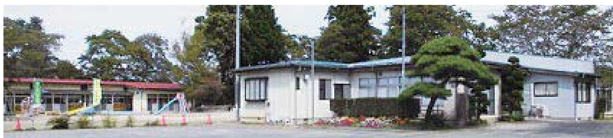
▲今年度に解体予定の施設（沢田自治センター・沢田児童館）の跡地（約2,200坪）
