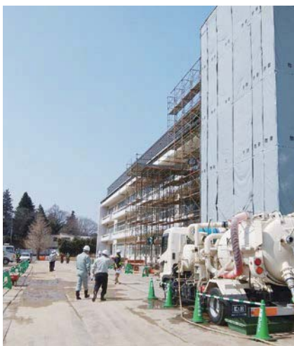
▲石綿除去工事が進む旧石川小校舎
