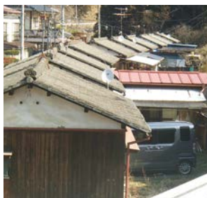
▲立ヶ岡にある町営住宅
