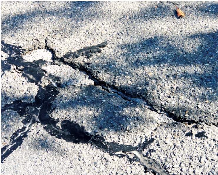
▲傷みが激しい町道
