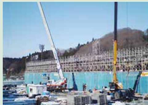
▲新校舎南側 第1・第2工区
