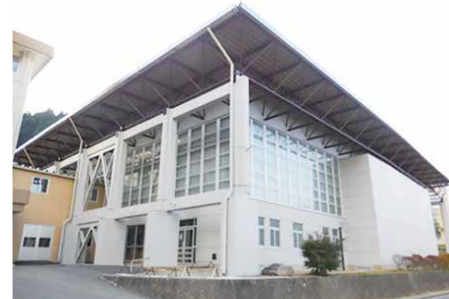
▲石川中学校屋体耐震補強・大規模改修事業
