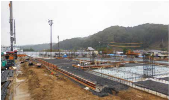
▲杭打ち工事が完了
