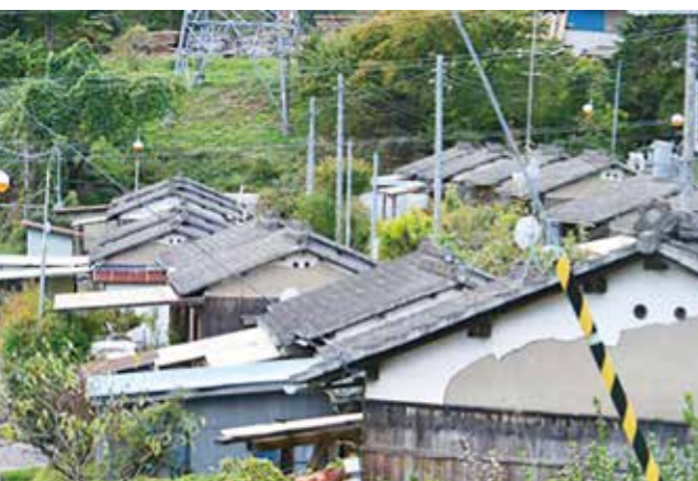
▲老朽化が進み早期改善・整備が望まれる町営団地
