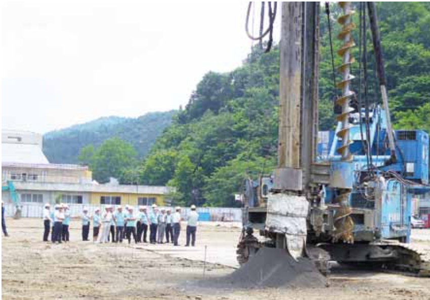
▲転石により、ハンマー工法からドリルハンマー工法に変更された
