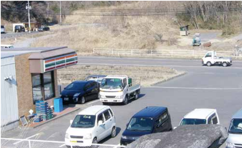
▲早期開通が待たれる石川バイパス。写真は第1工区入り口付近
