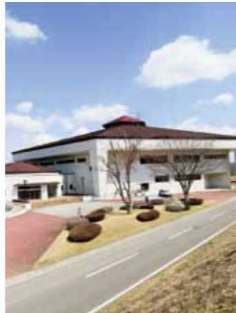
▲防災拠点の総合体育館に、太陽光発電と蓄電設備が設置される
