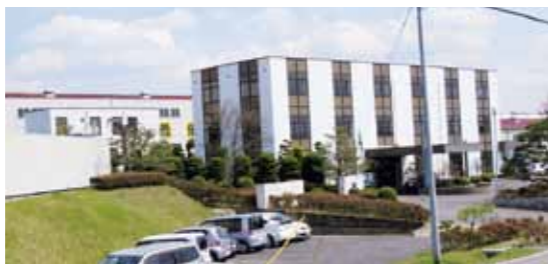
▲三井金属アクト石川工場の跡地利用は
