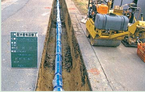
▲平成23年度配管布設替工事（双里字七畷石地内）
