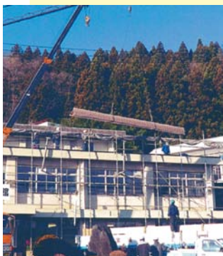
▲公民館屋根改修工事
