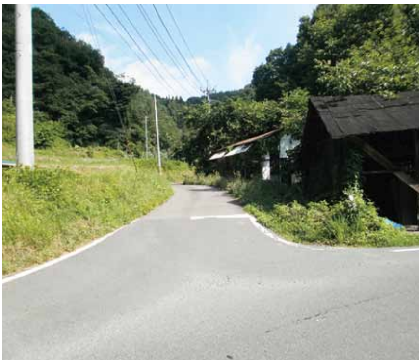
▲工事が一部未着工のままの町道111号線
