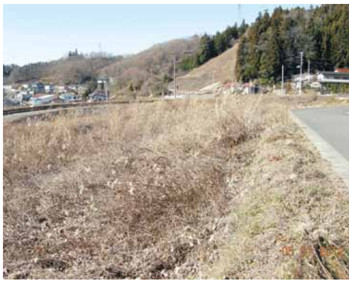
▲着工から11年が過ぎても開通しない石川バイパス（境ノ内地内）
