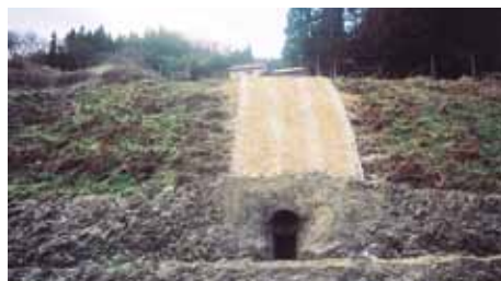
▲用水路災害復旧工事（中田字迎高野地内）
