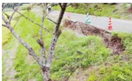
▲台風15号の災害復旧（板橋字北浮庭地内）
