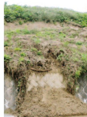
▲台風災害復旧工事(板橋字坊屋敷)
