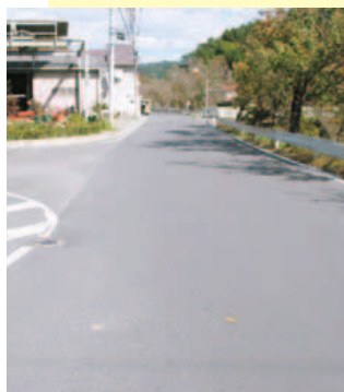
▲舗装改修工事（古館地内）
