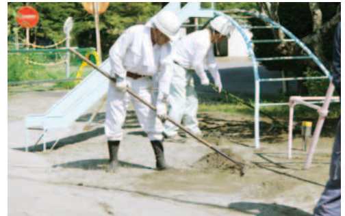
▲保育所表土除染作業（野木沢保育所）
