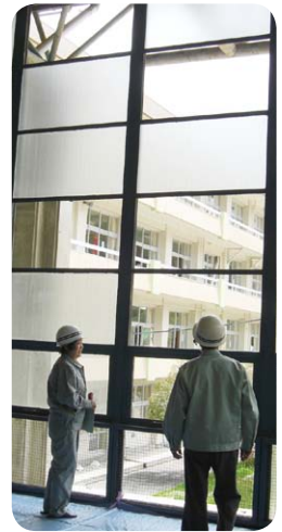
▲石川中体育館ガラス破損
