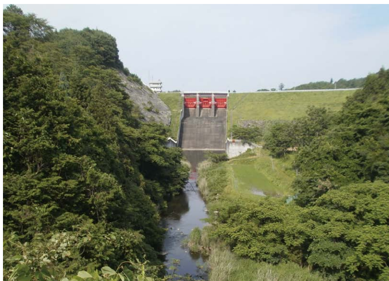
▲今回の震災でも影響がなかった千五沢ダム
