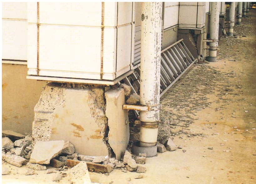
▲大きな被害を受けた、沢田中学校体育館
