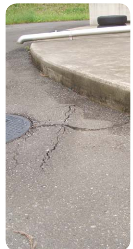
▲赤羽浄水場地盤沈下
