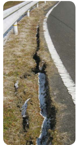
▲道路被害状況
