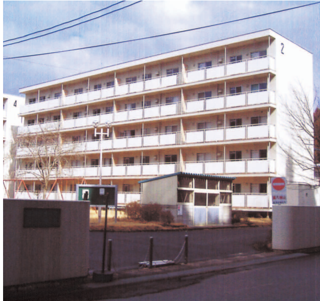
▲雇用促進住宅（字矢ノ目田地内）
