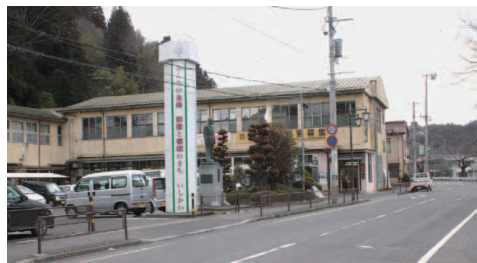
▲新庁舎建設が計画されている現庁舎
