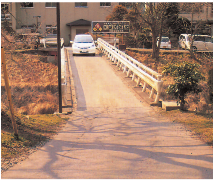
▲拡幅が望まれる猫啼橋(字猫啼地内)
