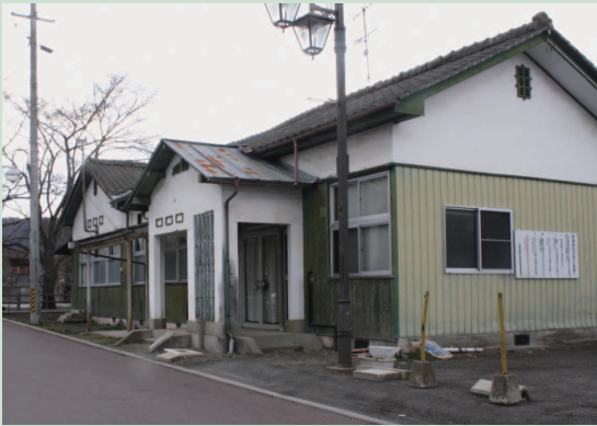
▶石川自治センターとして利用される旧水道事業所
