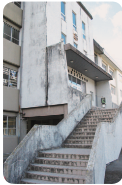
▲石川中学校耐震工事
