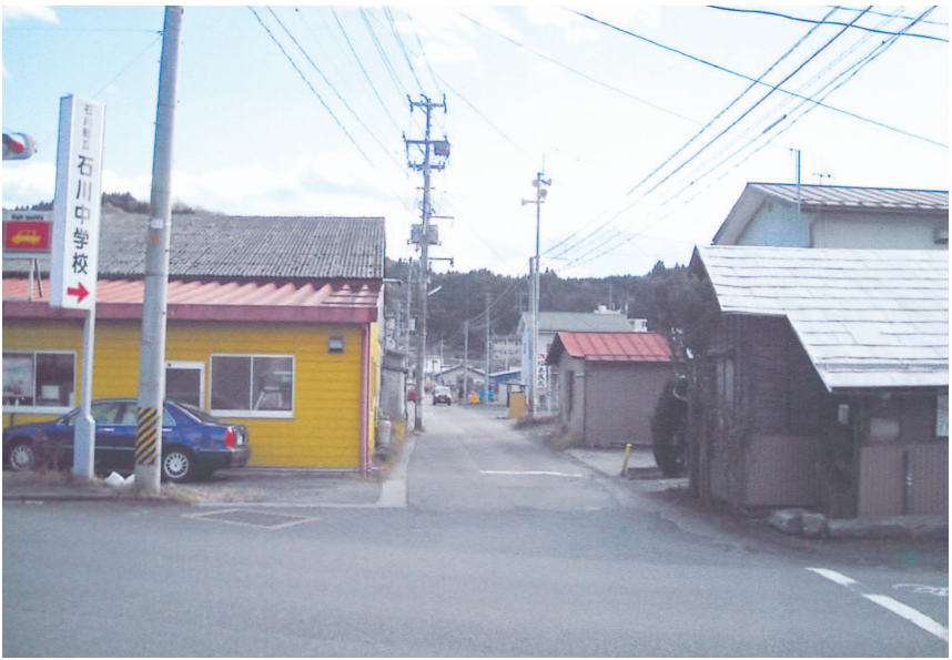
▲整備が早く望まれる町道115号線(双里字谷津前地内)
