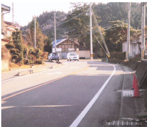
▲事故の多い沢井字根宿地区内
