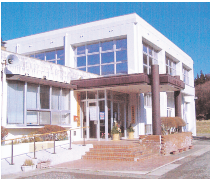
▲きめ細かな交付金で屋根を改修する中谷自治センター
