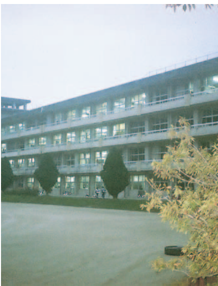
▲耐震工事を行っている石川中学校
