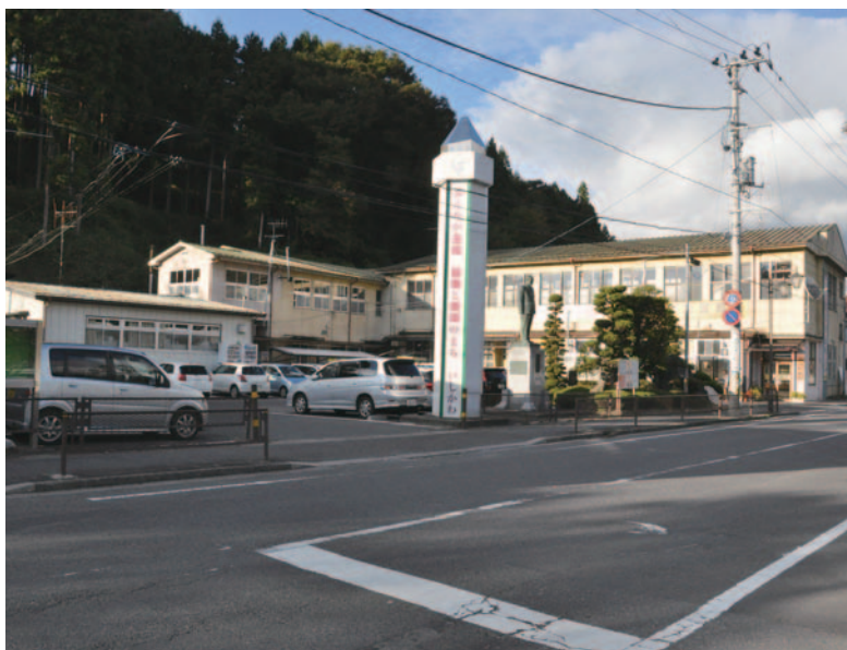
▲冷房設備が整っていない石川町役場
