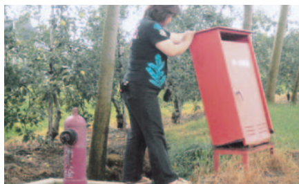
▲老朽化が進むホース格納庫
